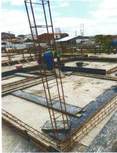
ARMAÇÃO DE SAPATA, VIGA BALDRAME E PILAR
