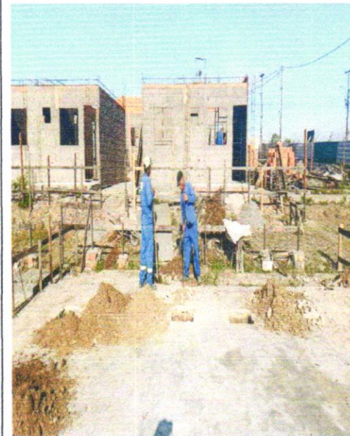
ESCAVAÇÃO MANUAL PARA SAPATA ISOLADA
