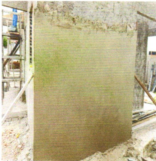
APLICAÇÃO DE REBOCO
