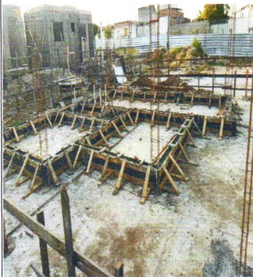
MONTAGEM E CONCRETAGEM DE PILARES
