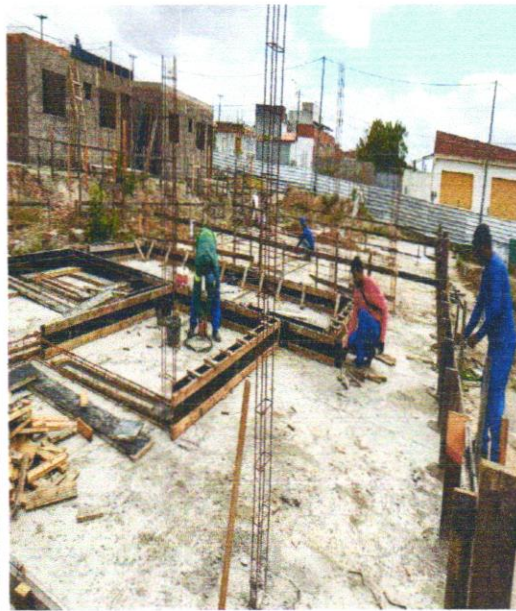
ARMAÇÃO DE SAPATA, VIGA BALDRAME E PILAR
