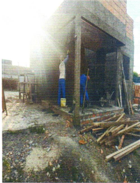
APLICAÇÃO DE REBOCO
