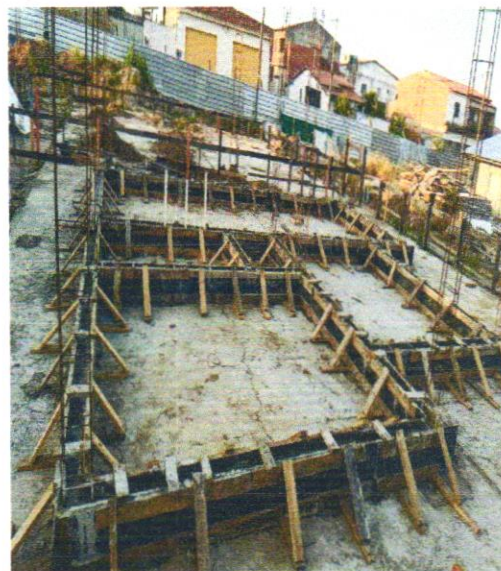
ARMAÇÃO DE SAPATA, VIGA BALDRAME E PILAR
