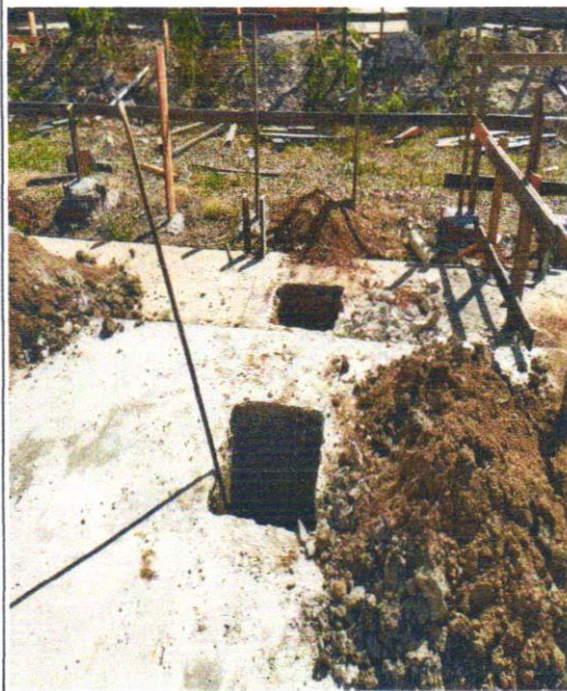
ESCAVAÇÃO MANUAL PARA SAPATA ISOLADA
