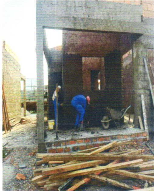
APLICAÇÃO DE REBOCO
