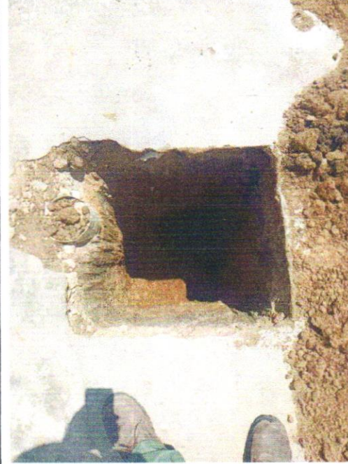
ESCAVAÇÃO MANUAL PARA SAPATA ISOLADA
